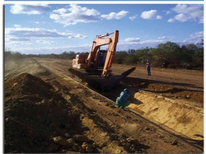
Foto 8 – Abertura de um canal com uma escavadeira Poclairn com concha de formato trapezoidal.
