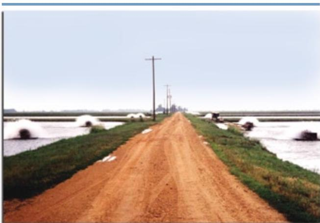
**Foto 1** – Viveiros de 4ha de uma fazenda de produção de “striped bass” nos Estados Unidos. Observe a borda livre gramada e a inclinação suave dos taludes. O topo do dique é largo o suficiente para o tráfego seguro de caminhões pesados. Note a rede de energia que dá suporte aos aeradores de 10HP instalados nos viveiros.
