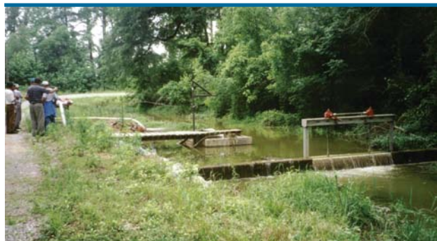
Foto 1a – Dreno coletor da água de drenagem dos viveiros. A comporta possibilita a opção de descartar ou não a água drenada.
