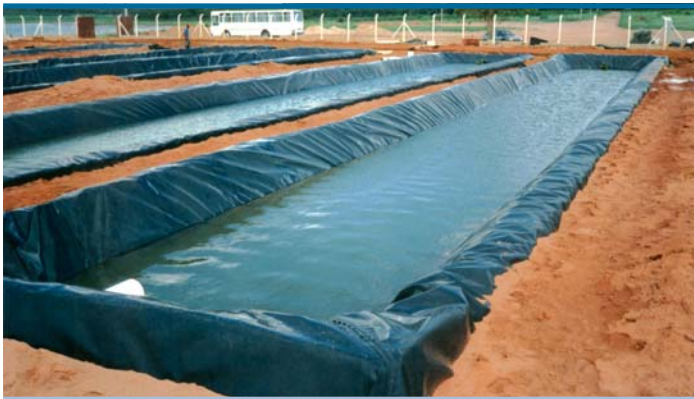
Foto 2 – Tanque construído em solo arenoso e revestido com filme de polietileno para eliminar as perdas de água por infiltração.
