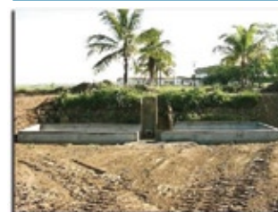
Foto 7 - Vista frontal de uma caixa de manejo em construção. Observe a comporta frontal que permite a entrada dos peixes e o monge adjacente à caixa.
