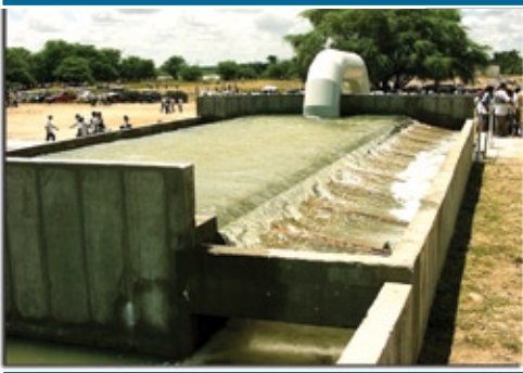
Foto 5 - Filtro horizontal de tela para impedir a entrada de detritos e de peixes indesejáveis nos canais de abastecimento (MPE - Paulo Afonso, BA).
