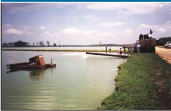
Foto 3 - Observe a inclinação do tubo de abastecimento que chega ao viveiro. Note a cobertura vegetal na borda livre do dique e a presença de veículos pesados trafegando sobre o mesmo.
