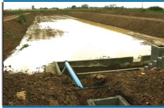
Foto 4 - Viveiro em reforma com o tubo de abastecimento posicionado na caixa de manejo. Observe à direita da foto a escada de acesso à caixa de manejo e ao monge (CODEVASF - EPI - Porto Real do Colégio, AL).
